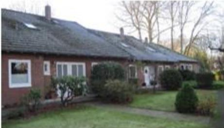
Fassaden: auf den Vorderseiten Verblendung mit Rotziegeln, rückwärtig Holzverbreterung im Obergeschoß und halbseitig weißer Putz und Rotziegel im Erdgeschoß. Weiße Fenster und Hauseingangstüren aus Kiefernholz, weiße Garagentore, Hauseingangstüren mit seitlichen Erweiterungen aus Glasbausteinfeldern.
