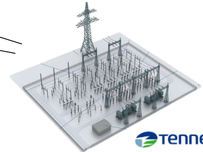
380-kV und 110-kV Schaltanlagen inklusive Transformatoren
