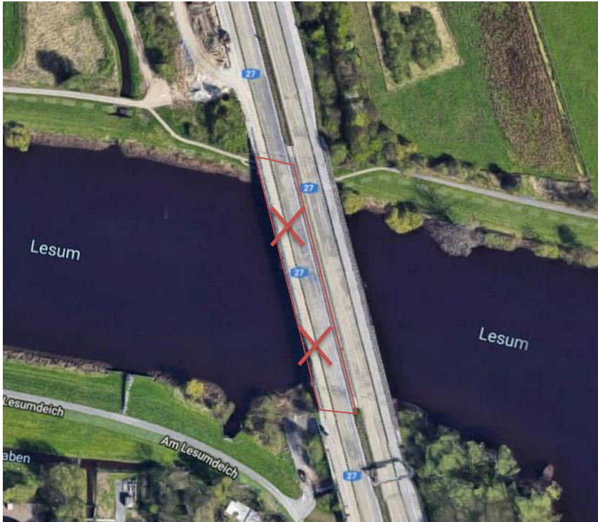
Luftbild Lesum-Brücke, A 27
